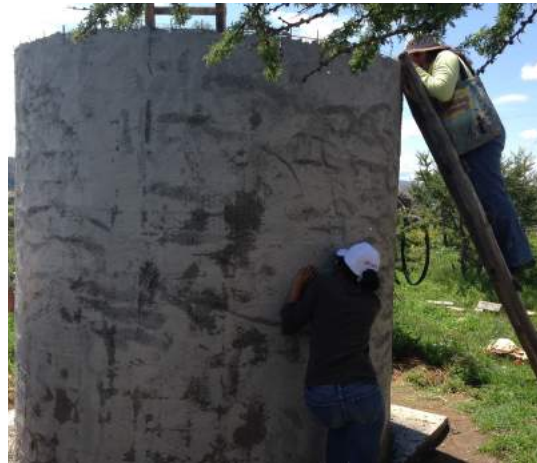
Figura 3.10 — Una cisterna en proceso con pared y base completadas.
