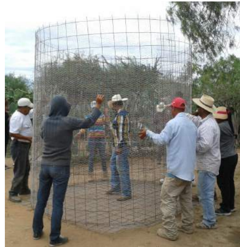
Figura 3.8 — Un grupo construyendo una cisterna sostiene su armado cilíndrico y su base.
