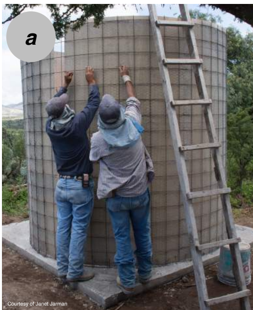
Figure 3.11 — Una cisterna en proceso con la base terminada con casi toda su cimbra sujeta. La misma cisterna se muestra desde el interior (a) y desde afuera (b).
