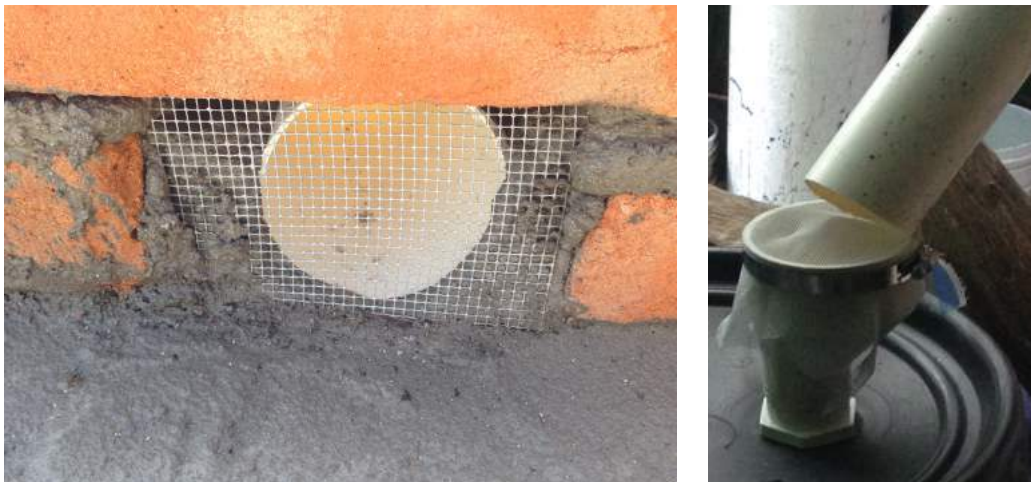
Figura 6.1 — Varios filtros de hojas: un ejemplo de un filtro de hojas instalado (a) en la entrada del sistema de canaletas desde el techo y (b) en la entrada al sistema de primer separador de aguas.
