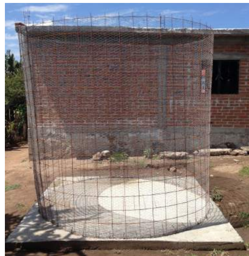
Figura 3.9 — El armado cilíndrico de la malla se eleva sobre una base de concreto firme y acabada.
